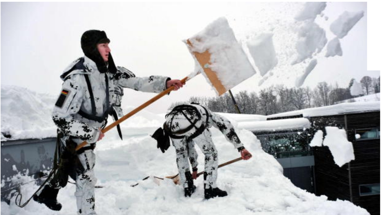
Schaufeln, was das Zeug hält: Soldaten der Ingolstädter Gebirgspioniere helfen in Miesbach aus, um das Krankenhausdach vom Schnee zu befreien.
