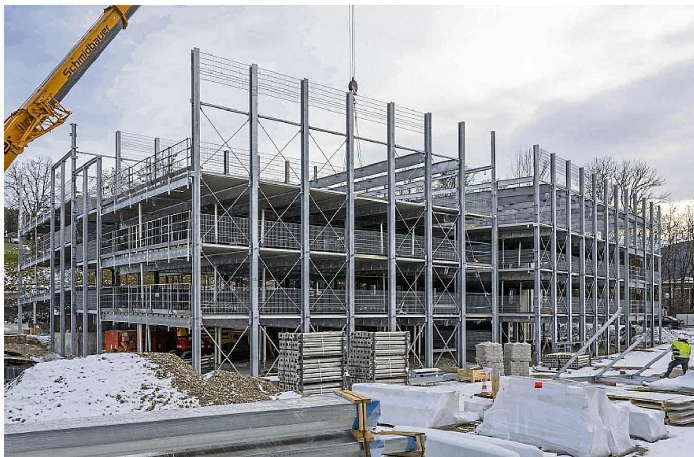
Macht beeindruckende Fortschritte: der Neubau des Parkdecks am Krankenhaus Agatharied. TP
